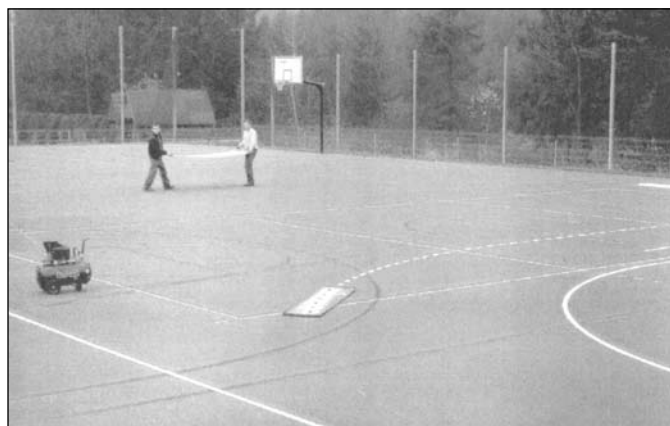
Końcowa faza robót – malowanie linii rozgraniczających boiska
