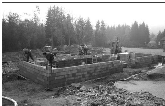
Prace przy budowie zaplecza sanitarno - szatniowego
