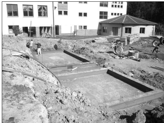
Wykonanie fundamentów pod budynek zaplecza sanitarno - szatniowego
