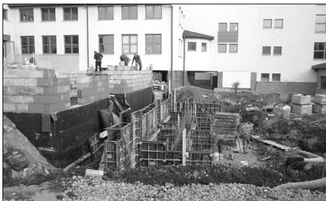
Budowa pochylni dla niepełnosprawnych
