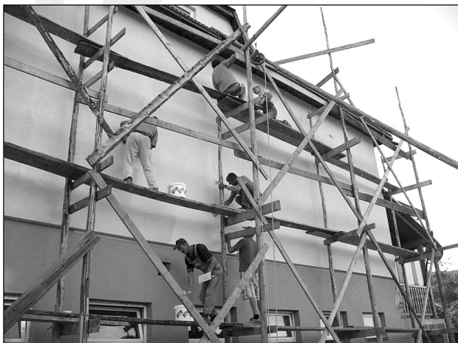
Praca wre - nakładanie akrylu
