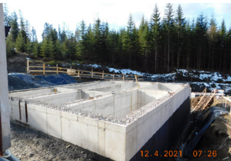
Oczyszczalnia ścieków Pustki | fot. Edyta Kukuczka
