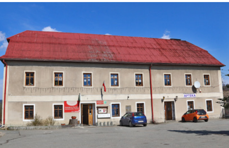
Gminny Ośrodek Kultury Budynek, stan na kwiecień 2021 | fot. Jacek Kohut
