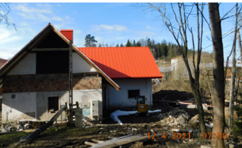
Budynek oczyszczalni ścieków Gliniane | fot. Edyta Kukuczka
