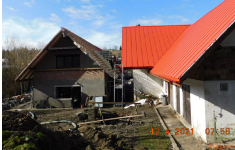
Budynek oczyszczalni ścieków Gliniane | fot. Edyta Kukuczka
