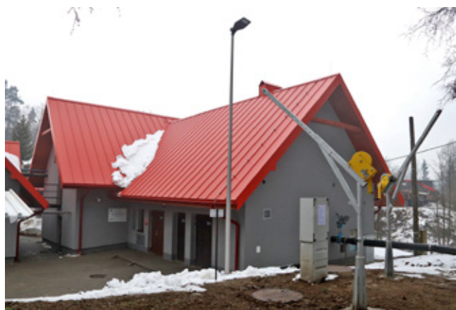
Zmodernizowana oczyszczalnia ścieków w Istebnej-Glinianym | fot. Jacek Kohut
